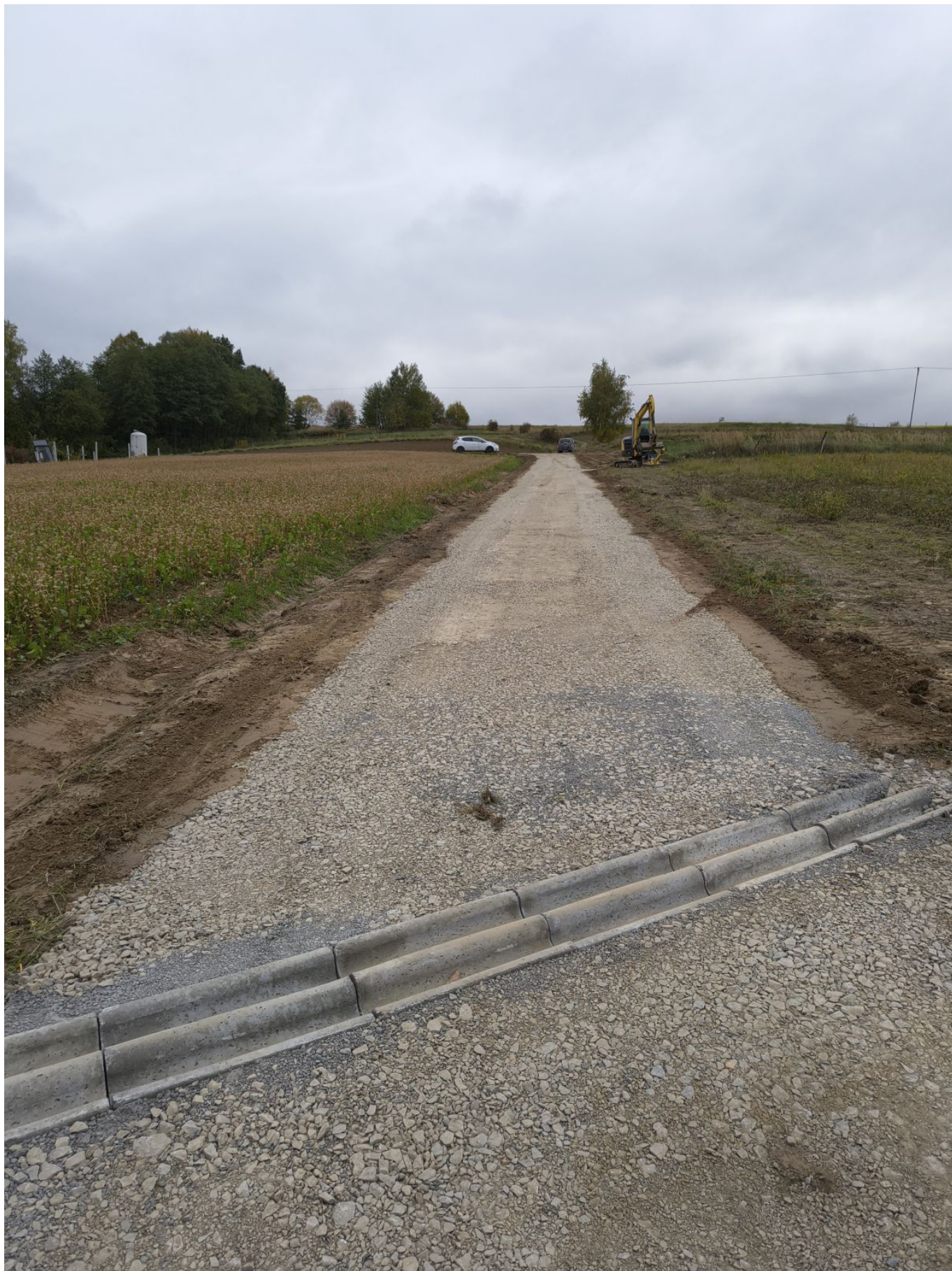
19 października 2026 r. zakończono i odebrano kolejną inwestycję drogową na terenie Gminy Hyżne. Tym razem zmodernizowano drogę dojazdową do gruntów rolnych w miejscowości Dylągówka (działka nr 2406).
